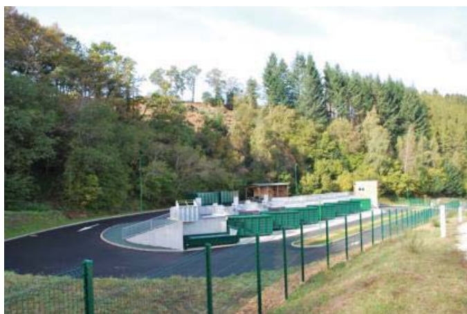
Déchetterie de St Cernin
