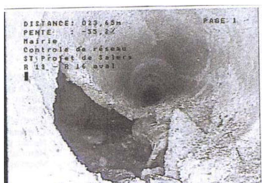
Clichés de l'inspection des conduites d'eaux usées.
