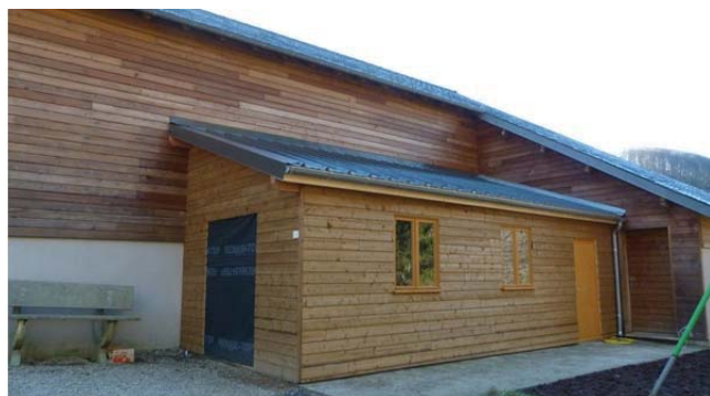
Le local chasse nouvellement agrandi.
